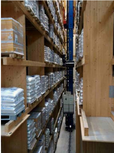
Bild 1. Holz ist ein ungewöhnlicher Baustoff für ein Hochregallager. Für das Salzlager der Salinen Austria AG jedoch ideal.
